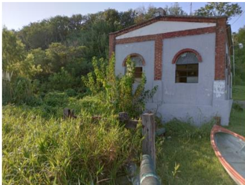
FIGURA 81.SALA DE BOMBAS DE TOMA DE AGUA.
