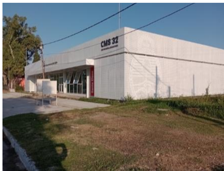
FIGURA 86.CENTRO MODULAR SANITARIO N°32.
