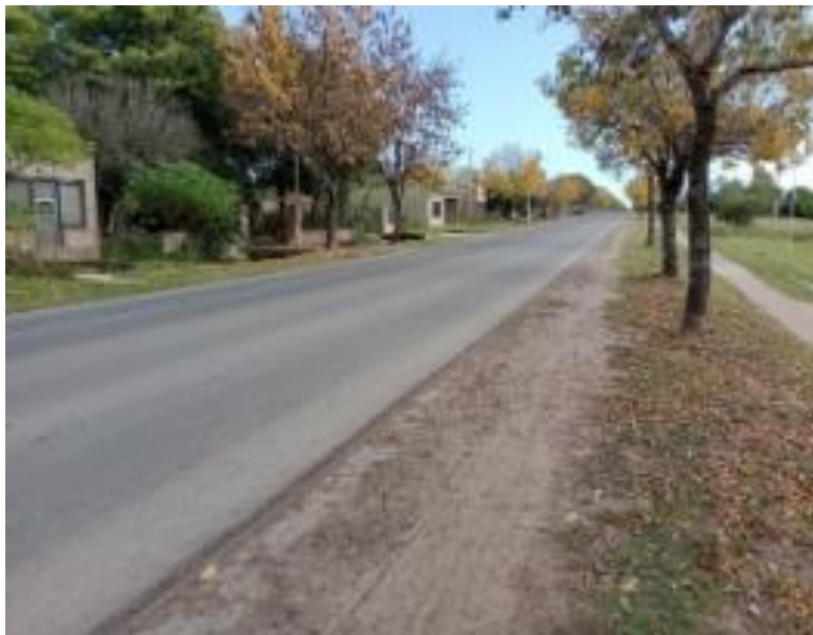
FIGURA 35. VISTA AV. JUAN DOMINGO PERÓN. UBICACIÓN ESTACIÓN DE BOMBEO N°7
