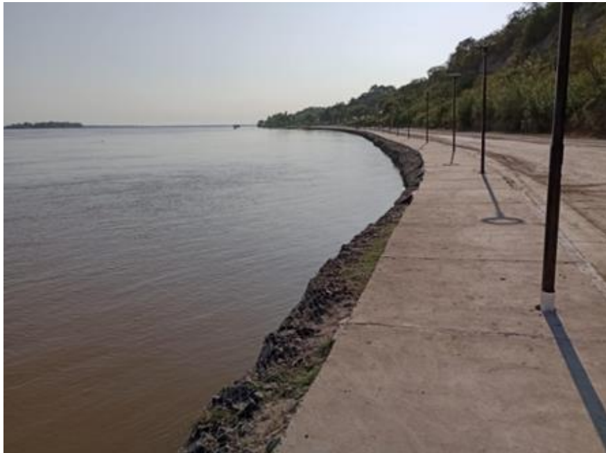
FIGURA 57. VISTA DE LA NUEVA COSTANERA (AGUAS ABAJO DEL PUNTO DE VUELCO)
