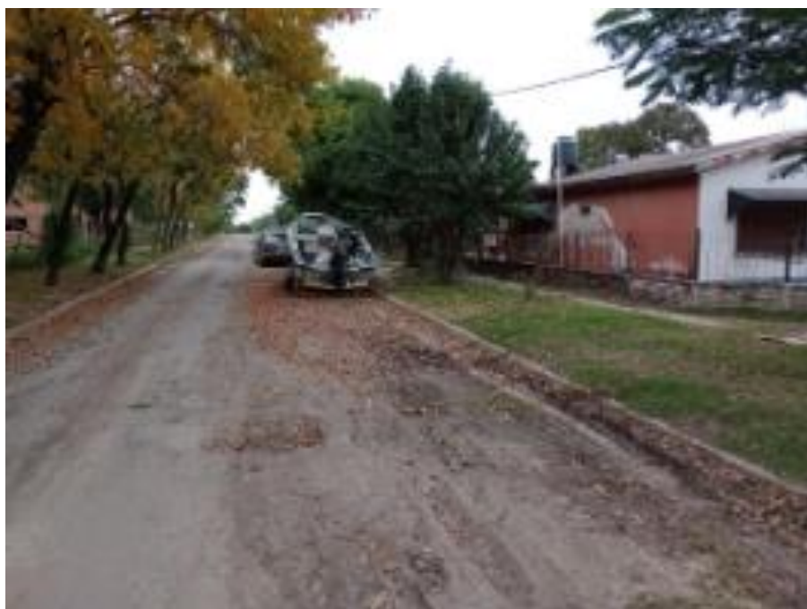
FIGURA 36. VISTA CALLE 10 DE NOVIEMBRE Y DE LA TORRE. ÁREA DE EXPANSIÓN DE COBERTURA CLOACAL.
