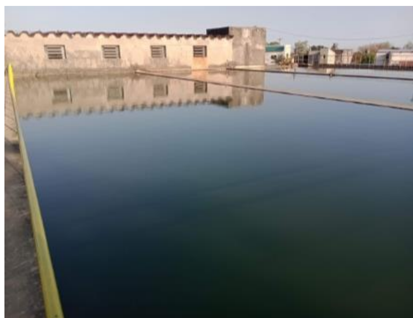
FIGURA 82.VISTA DE LA PLANTA POTABILIZADORA DE AGUA.
