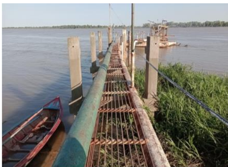
FIGURA 80. TOMA DE AGUA SOBRE EL RÍO PARANÁ.
